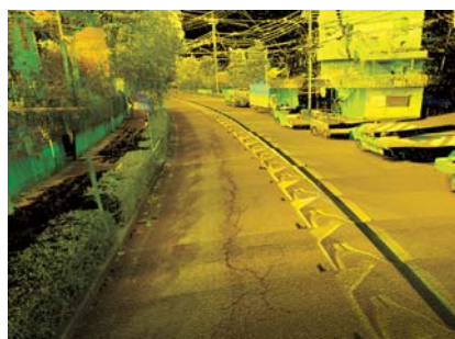
MMS測量で路面と 周囲の現況を3D測量
